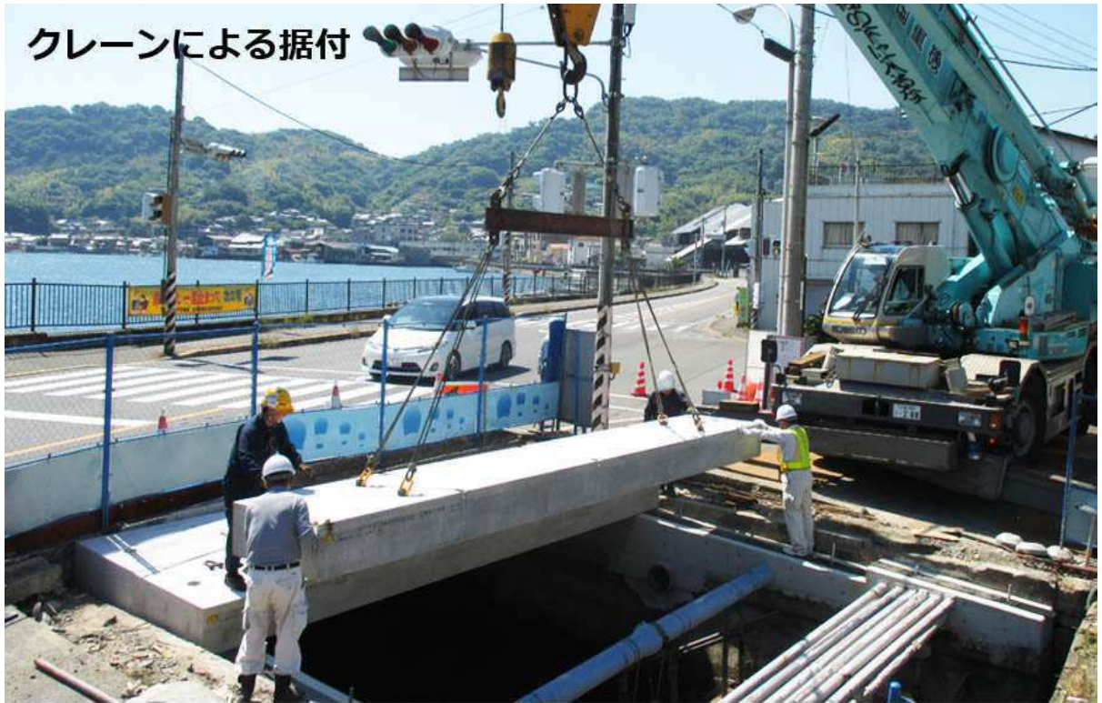
起重機船による据付
