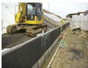
ドレーン材投入
