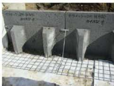
ブロック設置、金網取付
