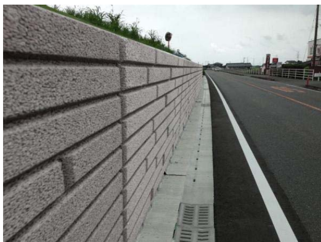
施工イメージ
