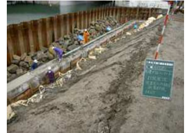
コンクリート打設
