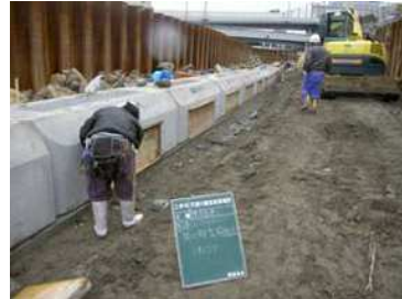
開口部型枠設置
