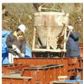
②コンクリート打設
