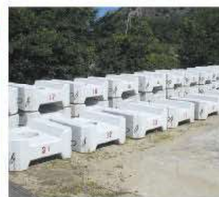
④型枠脱型
