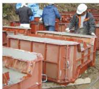
③コテ均し、養生
