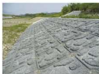
連結部碎石処理
