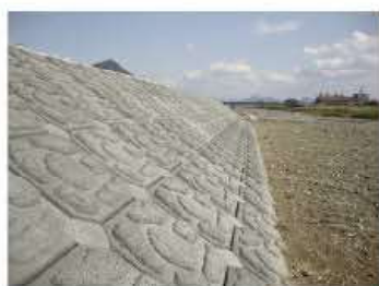
連結部着色コンクリート処理
