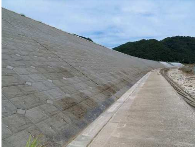
江の川都賀西地区第2護岸外工事
