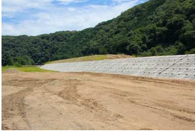
令和2年度江の川片山地区中流築堤外工事
