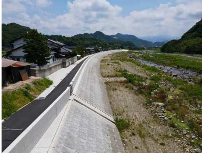
日野川立石地区築堤護岸他工事
