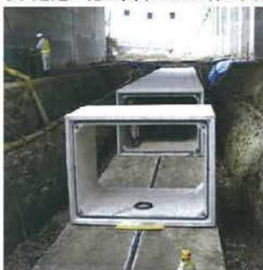
高架下でのボックスカルバート搬送・据付け工法
