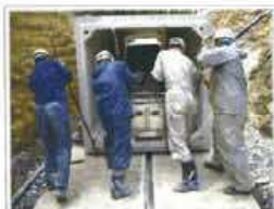
▲ボックスカルバート搬送作業 左右位置調整作業
