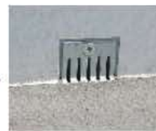
車道部排水孔 (50cm間隔)
