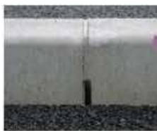
歩道部排水孔
