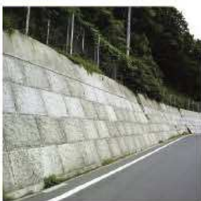
道路改良工事
