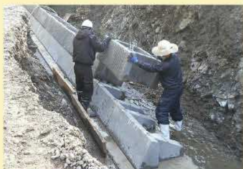
③ 2 段目以降、本体ブロックを据付
