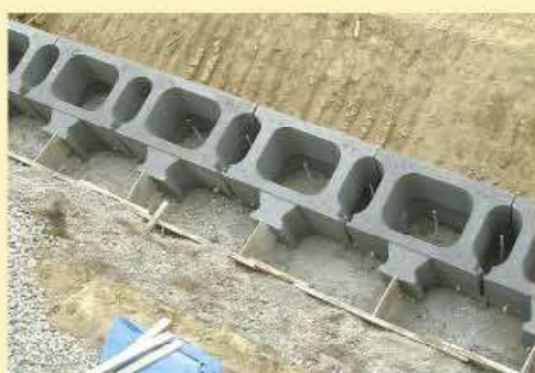
⑤ ブロック背面を設計書に基づいた裏込め材料で埋め戻し、ブロック形状・裏込コンクリートの有無に応じ抜き型枠を設置
