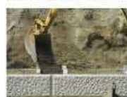
4.間詰材・裏込材投入
