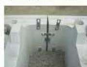
2.縦・横連結金具取付
