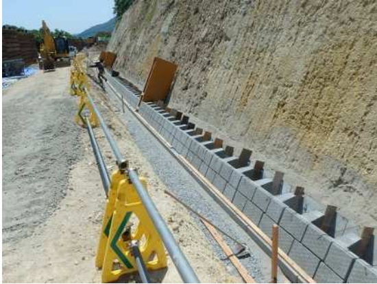
一段目設置状況
