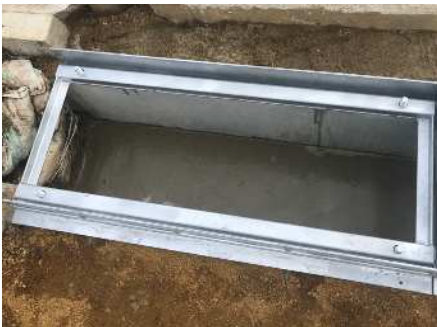
グレーチング受枠設置
