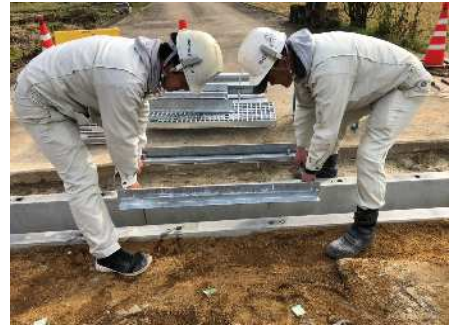
グレーチング受枠設置
