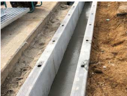
グレイン側溝の据付け
