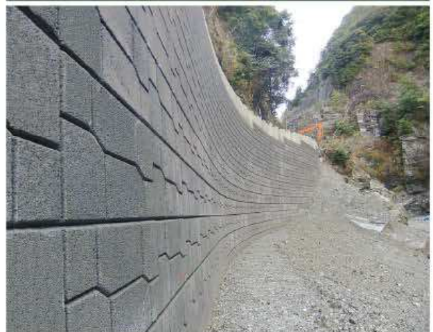
山間部道路拡幅 護岸工
