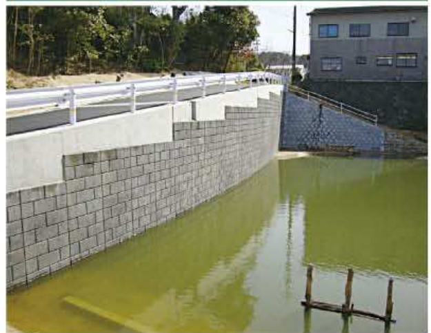
道路拡幅 護岸工
