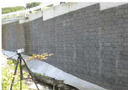
震度6強 最大高さ H=7.2\text{m} 異常なし
