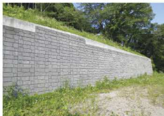
震度6弱 最大高さ H=6.7\text{m} 土羽付き 異常なし
