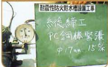
7 縦締工PC鋼棒緊張
