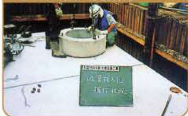
10 吸管投入孔据付
