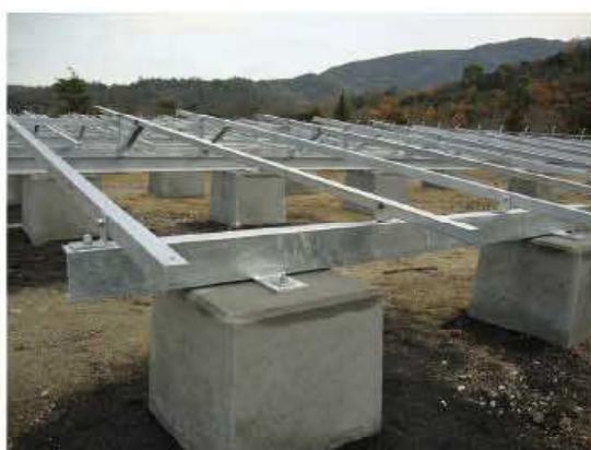
インサート固定状況
