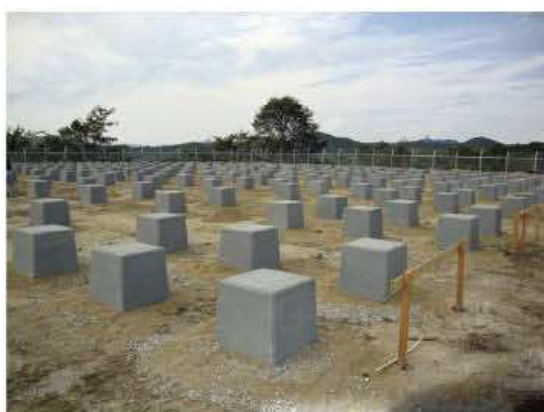
基礎ブロック設置状況
