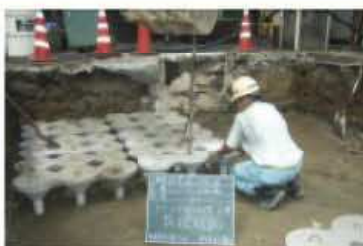
コマ型ブロック敷設
