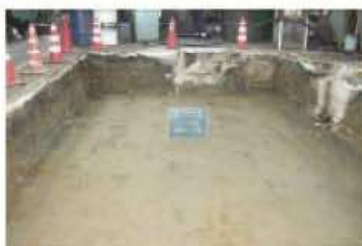
敷設面のチェック
