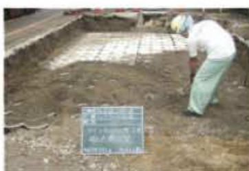
間詰碎石の充填・締め固め
