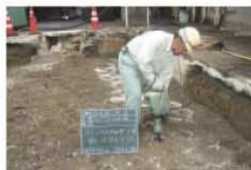
間詰碎石の充填・締め固め
