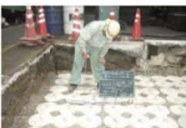
間詰碎石の充填確認
