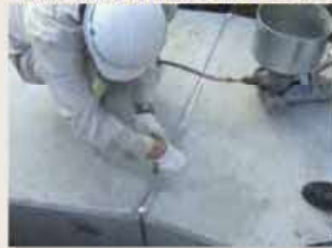
上部より頂版天端部へ注入(曲線部)
