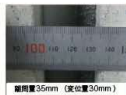
地震動により離間した状態
