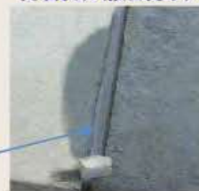
充填状況(接合完了)
