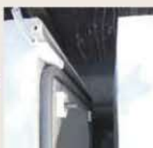
TBジョイントバー挿入状況
