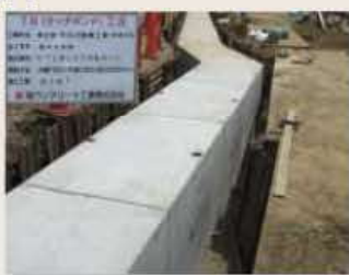
曲線部も直線部と同じ施工！
