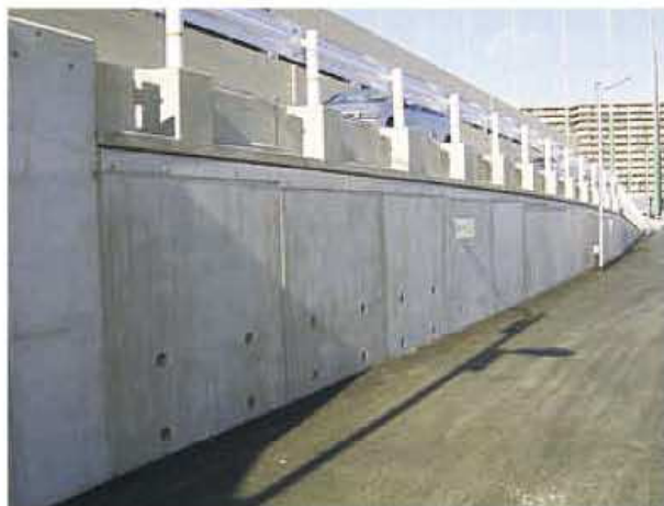
プレキャストL型擁壁直上
