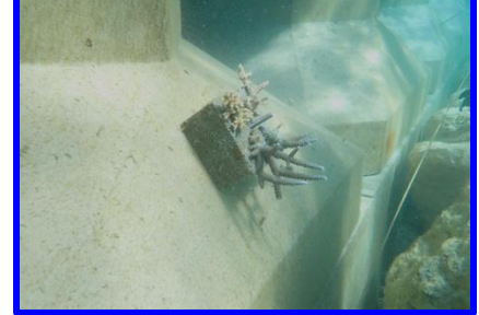
直立消波ブロックにアンカーを 打設し植付け(2024年3月) 水深1m
